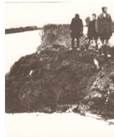
Bomkrater in de Eemskanaaldijk (zuidzijde) nabij toenmalige brug 4.
