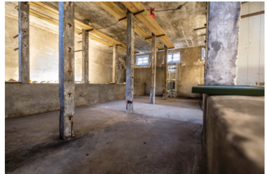
Kelder van de voormalige coöperatieve stoomzuivelfabriek Garmerwolde (1889-1919) aan de Dorpsweg 41
